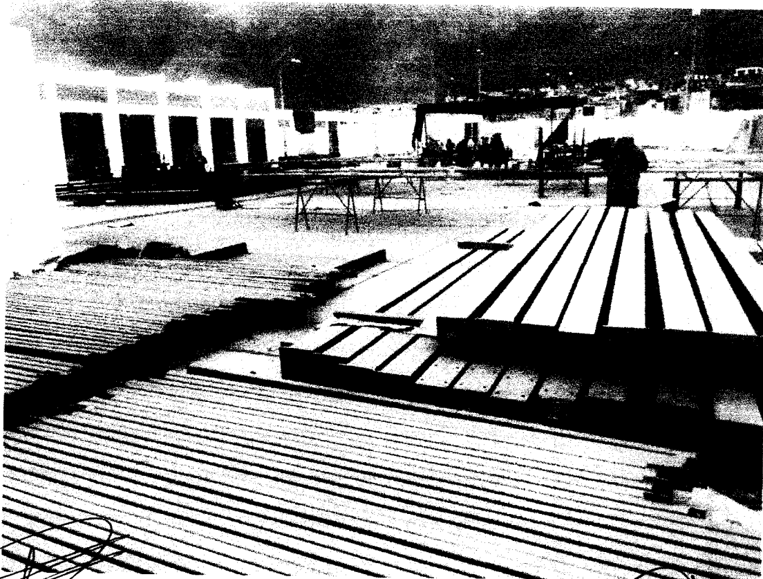
Fotografía N°06: Zona de secado de pintura.
