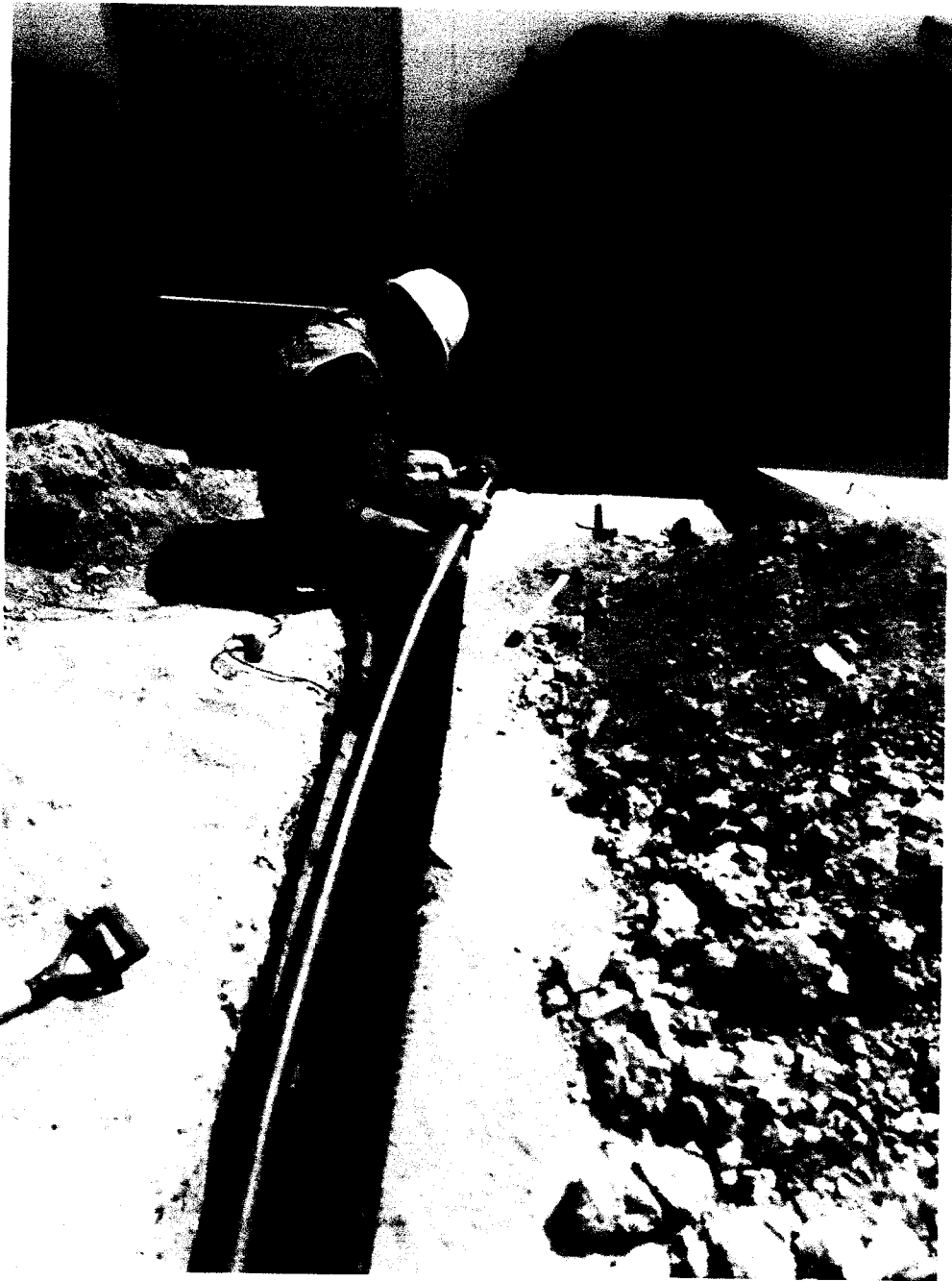
Fotografía N°09: Vista de trabajos de acople de tubería HDPE del adicional de obra.
