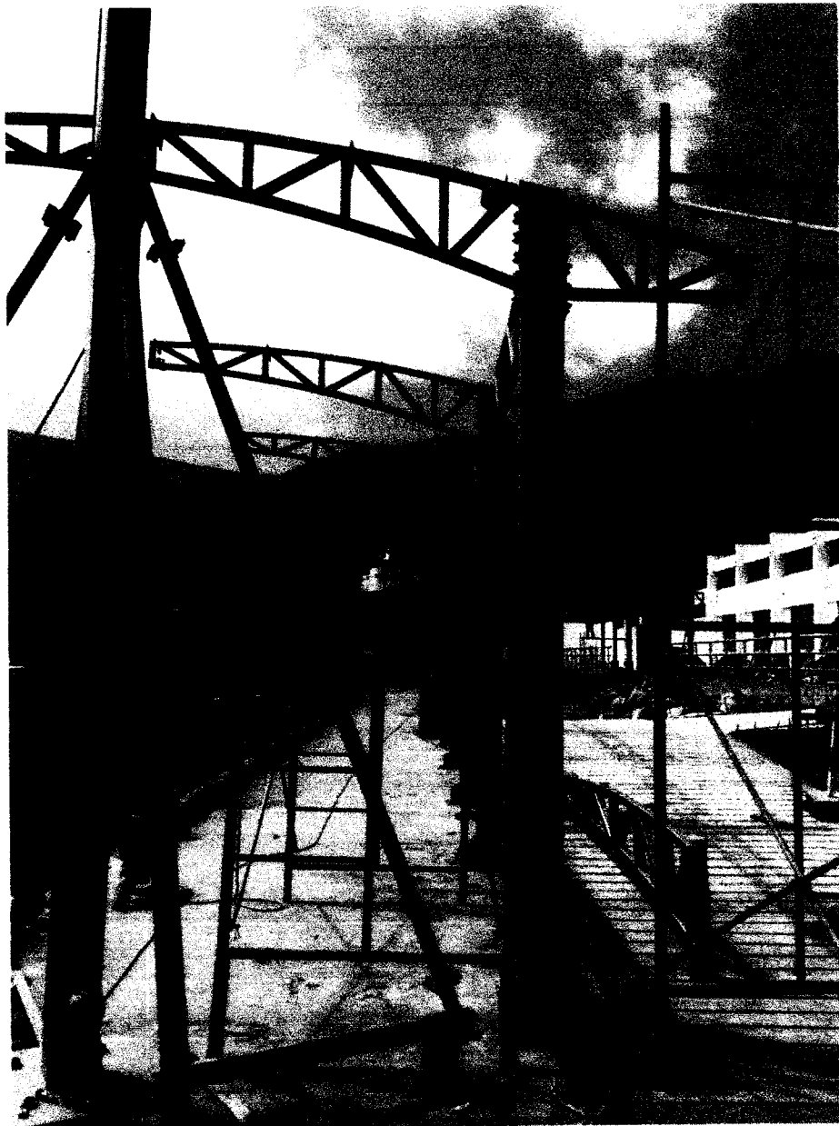
Fotografía N°04: Vista de montaje de estructura para cobertura tipo III.
