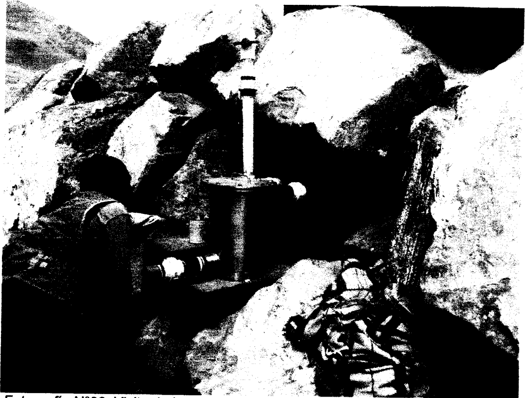
Fotografía N°02: Visita de instalación de trampa de pelos en línea de succión de agua salada.
